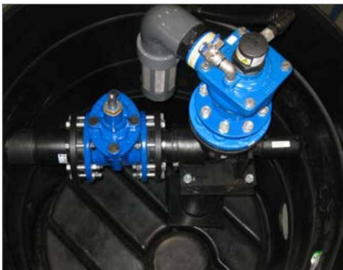
Studnia odpowietrzająco-napowietrzająca z zaworem zwrotnym
