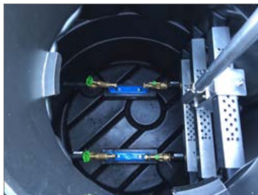
Studnia wodomierzowa ze zintegrowanym zestawem instalacyjnym
