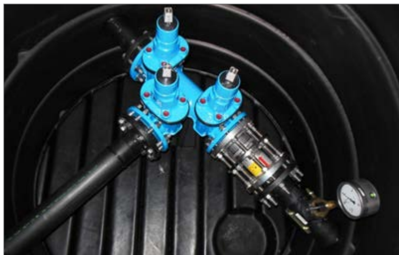
Zawór rozgałęźny z manometrem
