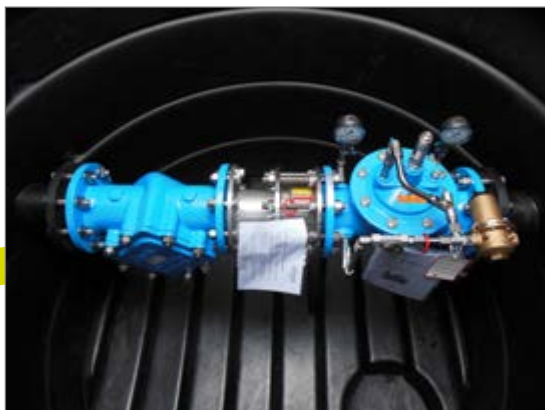
Studnia z zaworem redukcji ciśnienia
