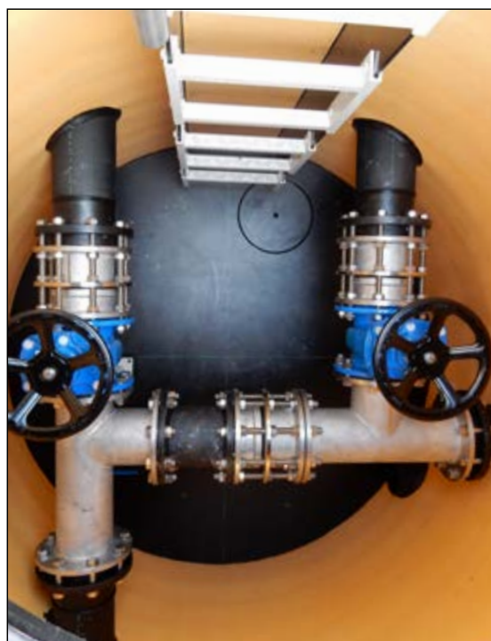
Studnia rozdzielacza z elem. ze stali nierdzewnej
