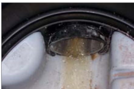
7.) Po utwardzeniu zaprawy, demontaż korków i udrożnienie przepływu.
