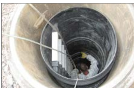
8.) Montaż elementów studni PE DN 800 za pomocą uszczelek elementowych.
