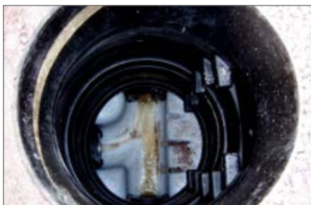
10.) Studnia po renowacji. Stopnie mogą zostać zdemontowane na życzenie klienta.
