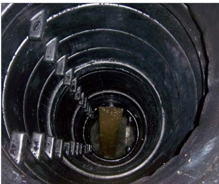
9.) Studnia po renowacji. Na życzenie klienta, stopnie zostały zdemontowane.
