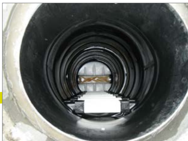
Nowa studnia PE DN 800 w skorodowanej studni betonowej DN 1000
