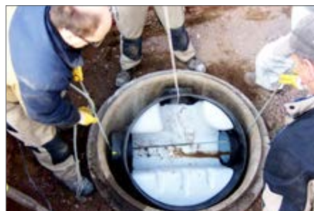
5.) Posadowienie kinety w istniejącej studni.
