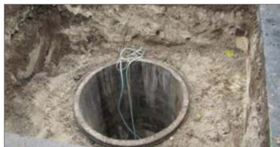
1.) Nacięcie asfaltu, demontaż betonowego stożka.
