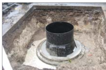
9.) Wypełnienie dystansu pomiędzy studnią PE DN 800 a studnią betonową DN 1000 zaprawą wypełniającą.
