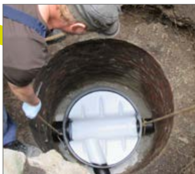
Posadowienie nowej kinety w studni
