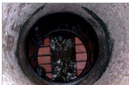
8.) Zainstalowany pierścień DN 800 na wcześniej zamontowanej uszczelce.
