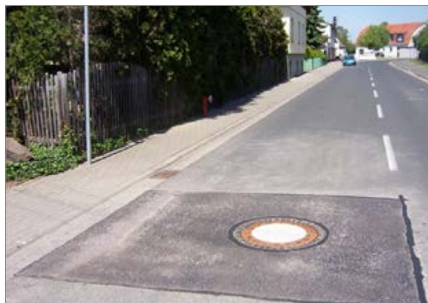
Odtworzenie nawierzchni drogi
