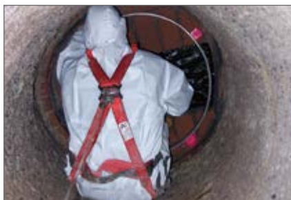
4.) Instalacja pierścienia montażowego na spoczniku.
