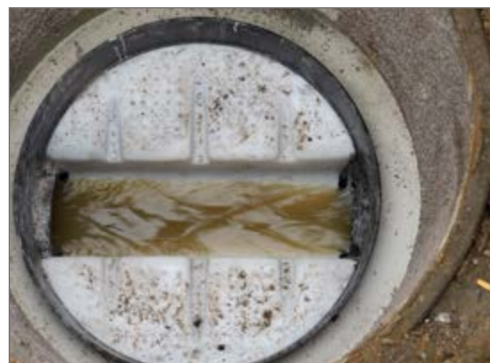
Renowacja: studnia w studni.
