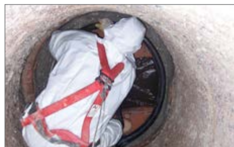
6.) Instalacja uszczelki elementowej ROMOLD na pierścieniu montażowym. 100 % szczelne połączenie z późniejszymi elementami.
