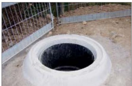
11.) Posadowienie pierścienia odciążającego.
