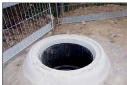
10.) Wypełnienie przestrzeni pomiędzy studniami. Odtworzenie konstrukcji drogowej, w tym pierścienia odciążającego.
