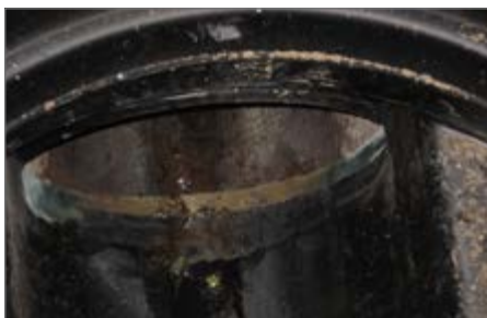
Połączenie króćców PE z istniejącymi kanałami za pomocą zmodyfikowanej zaprawy.
