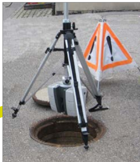
Szczegółowy pomiar istniejącej studni
