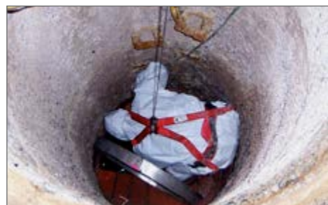
3.) Nacięcie asfaltu, demontaż betonowego stożka oraz stopni.
