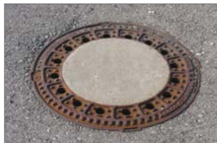
12.) Posadowienie pokrywy włazowej oraz odtworzenie struktury i nawierzchni drogi.
