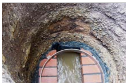
5.) Zamocowany pierścień montażowy.
