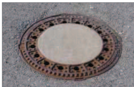
11.) Przywrócona podbudowa i powierzchnia drogi, w tym oddzielony właz z pierścieniem odciążającym .
