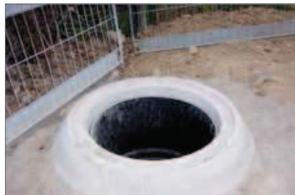
10.) Wypełnienie przestrzeni pośredniej. Odtworzenie konstrukcji nawierzchni z oddzielnym włazem na pierścieniu odciążającym.
