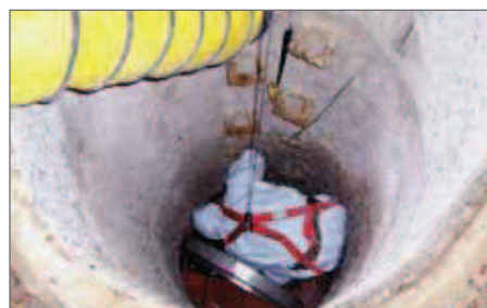
3.) Naciąć asfalt, podnieść i wyjąć stożek betonowy.
