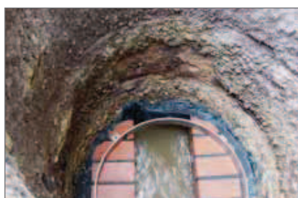
5.) Zdjęcie przedstawia przymocowany pierścień montażowy.
