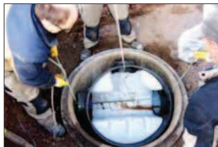
5.) Prefabrykowaną kinetę umieść w studni betonowej.
