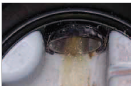
7.) Po utwardzeniu zaprawy zdemontować korki, udrożnić przepływ.
