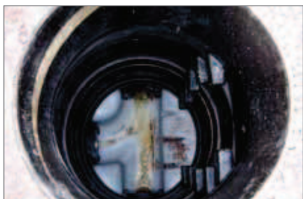
10.) Studnia po renowacji. Na życzenie klienta stopnie zdemontowane.
