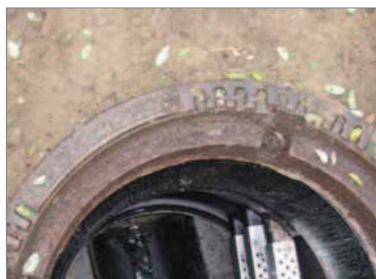
Studnia w studni po renowacji
