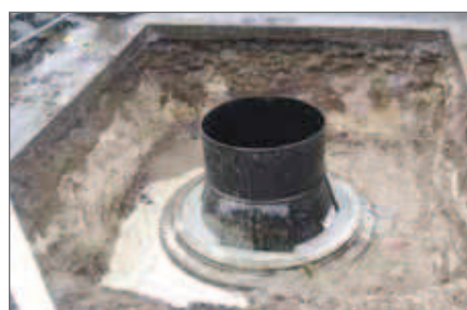
9.) Wypełnienie zaprawą przestrzeni między PE-Studnią DN 800 i betonową studnią DN 1000.
