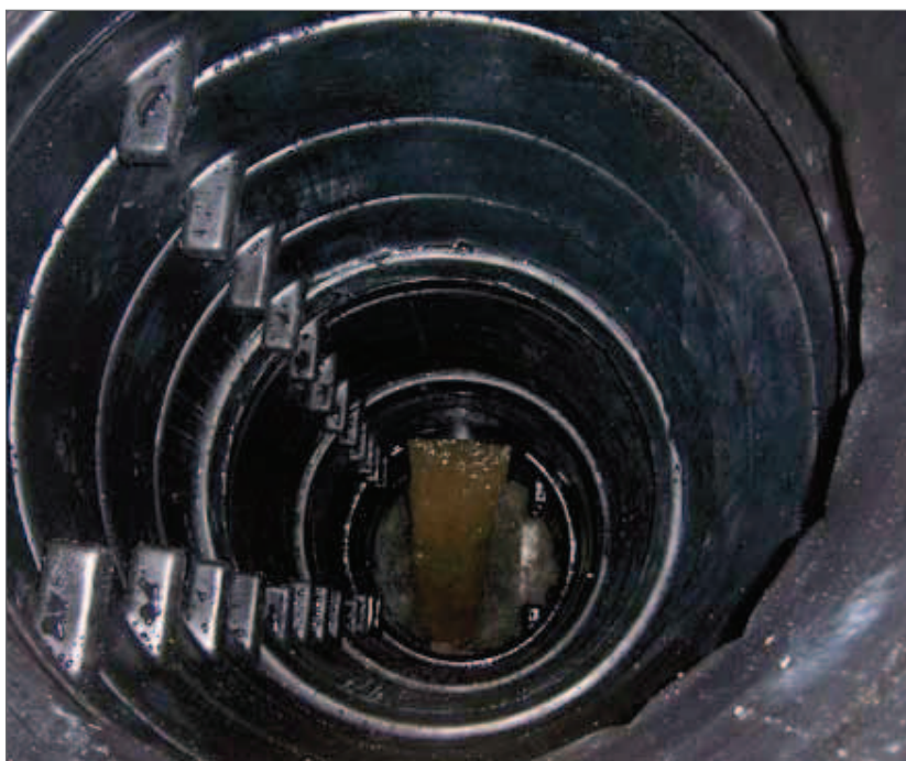
9.) Studnia po renowacji. Na życzenie klienta stopnie zdemontowane.
