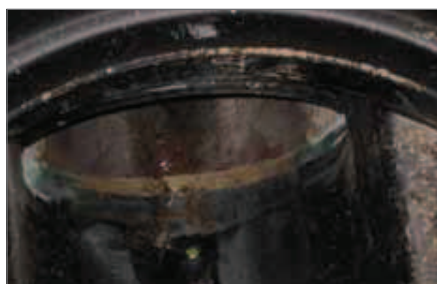
Połączony sztucer PE-rura, przestrzeń wokół wypełniona zmodyfikowaną zaprawą.
