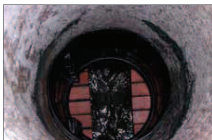
8.) Umieszczony PE element studni systemowej DN 800 z uszczelką międzyelementową.
