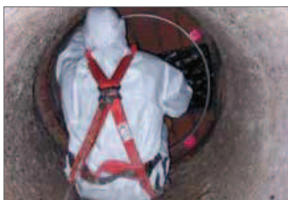
4.) Zamontować na spoczniku pierścień montażowy.
