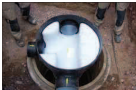
4.) Prefabrykowaną kinetę z PE-Sztucem dopasuj do potrzeb.
