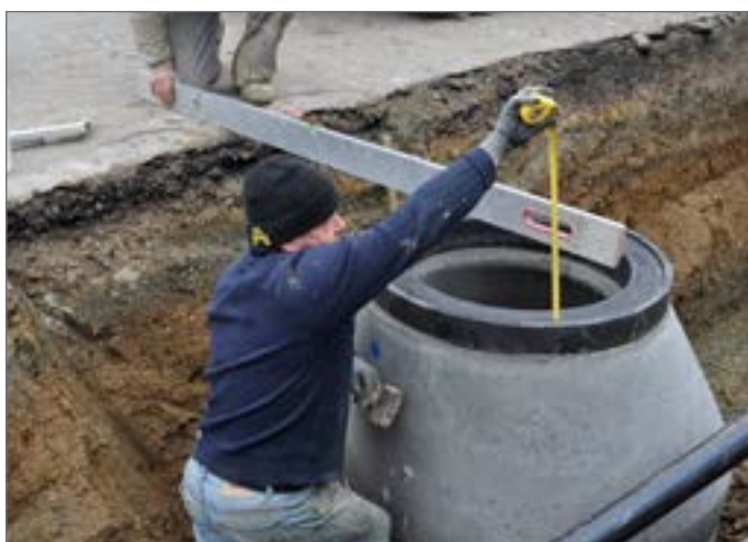
ustawianie i wypoziomowanie pierścienia ewentualnie nałożyć inne pierścienie
