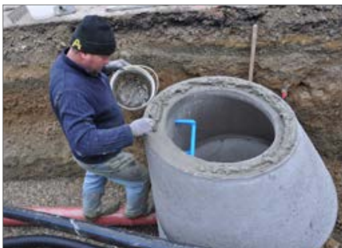
szybkie naniesienie zaprawy cementowej (wiążącej) (przykładowo PCI Polyfix Plus / lub PCI Polyfix Plus L)
