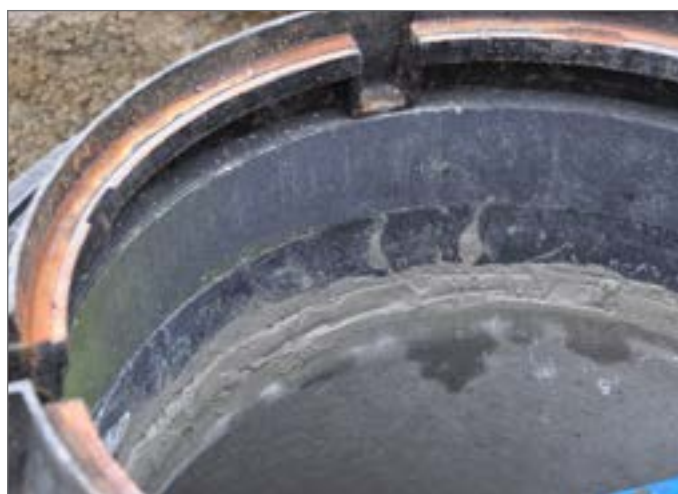
dla szczelnego połączenia (sklejenia) użyć np.: PU-klej konstrukcyjny firma Würth, numer kat. 0890100730 lub 08901003). i nałożyć wąż.
