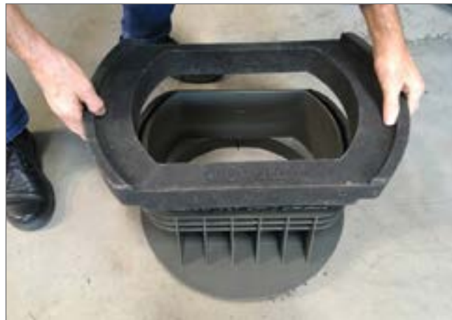
nałożenie i dociśnięcie pierścienia PDRD 50.30/xx VS na klej
