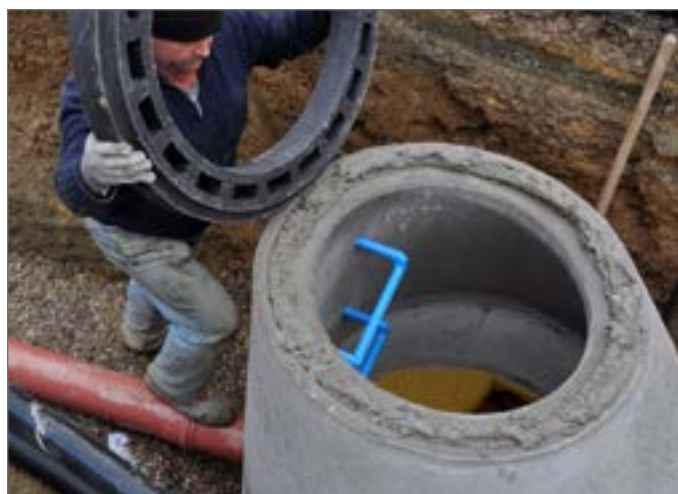
wybrać i założyć odpowiedni pierścień wyrównawczy (można wybrać także kombinację elementów)
