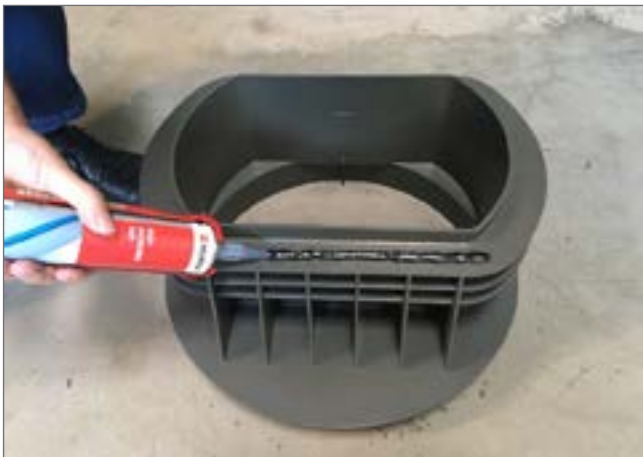
nałożenie kleju montażowego na wpust GRIT 40.50.30/13
