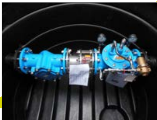
Studnia z zaworem redukcji ciśnienia
