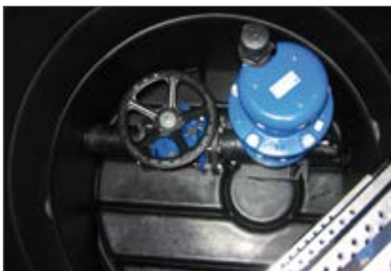
Kanał boczny jako odpowietrzająco-napowietrzający
