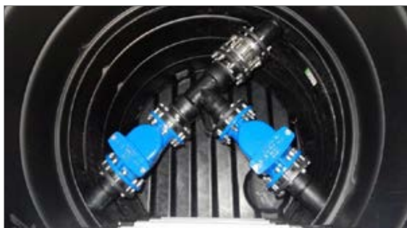
Trójnik z klapkami zwrotnymi
