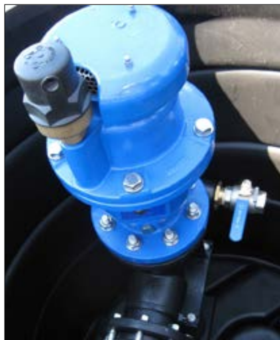
Studnia odpowietrzająco-napowietrzająca z opcją spustu
