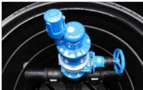
Kanał główny jako odpowietrzająco-napowietrzający
