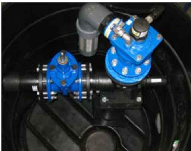
Studnia odpowietrzająco-napowietrzająca z zaworem zwrotnym
