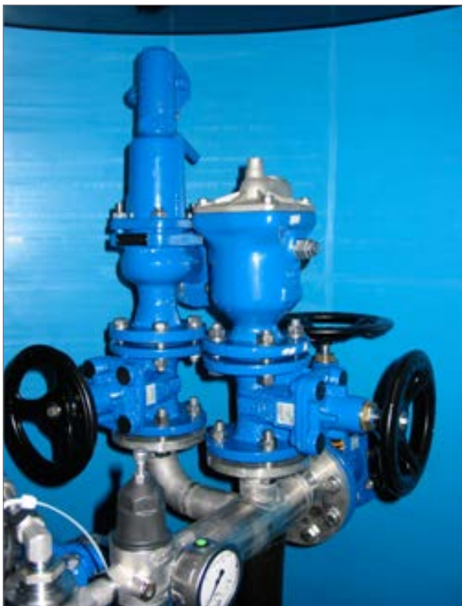
Studnia z reduktorem ciśnienia
