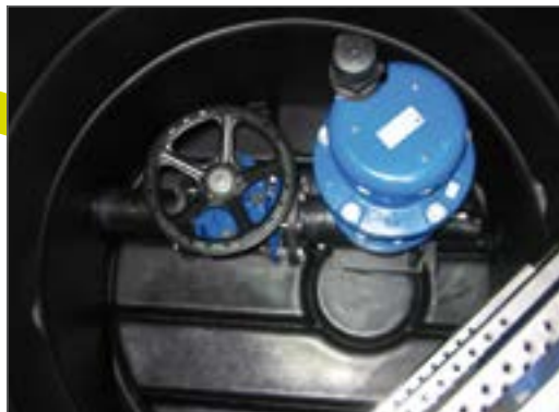
Studnia odpowietrzająco-napowietrzająca
