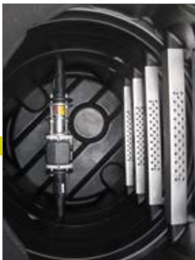
Studnia wodomierzowa ze zintegrowanym miernikiem przepływu MID
