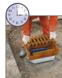
15. minuta: posadowienie kraty wpustowej
