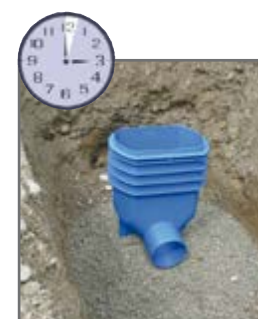
3. minuta: odpływ osadzony w chudym betonie
