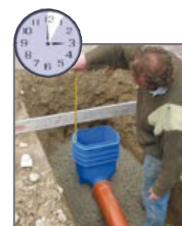
5. minuta: dokładne dopasowanie wysokości
